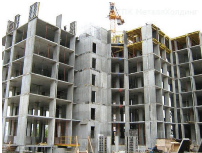
Рис.1. Устройство монолитных железобетонных стен, пилонов, колонн [1].
